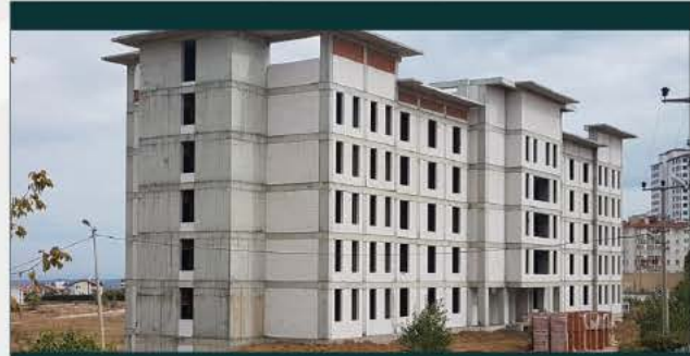
Kastamonu Yurt İnşaatı
